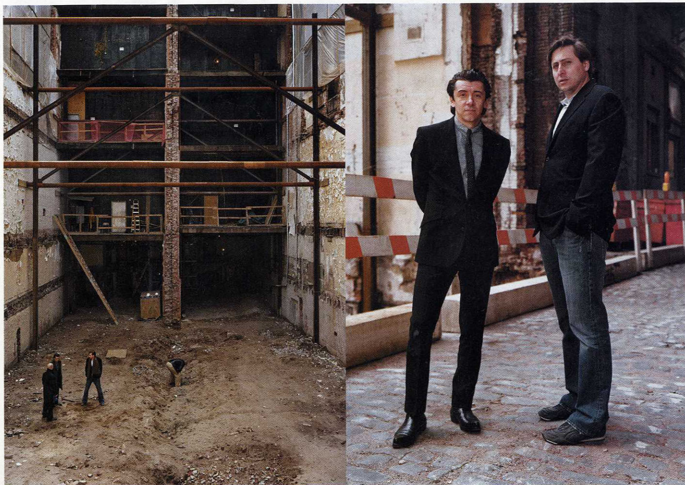
IN AANBOUW LINKS DE PLAATS WAAR FITNESSRUIMTE, SAUNA EN STOOBAD KOMEN. RECHTS: GELDSCHIETERS LEO TSIMMER (LINKS) EN DAVID KISLIN (RECHTS)
